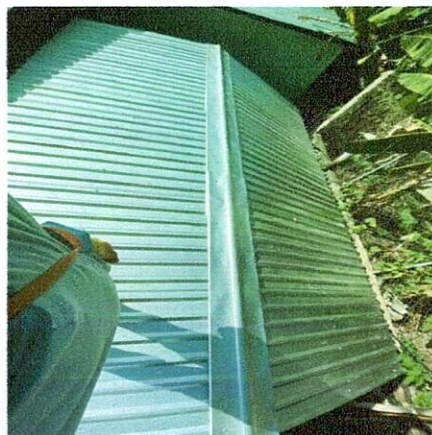
FOTO 2: Cambio de estructura de madera a metal y cubierta de lámina troquelada calibre 26, mejoramiento de puerta en area de cocina
