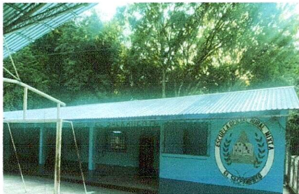
FOTO 1: Instalación de techo con estructura de metal tipo pórtico con cobertura de lámina troquelada calibre 26 a modulo 1, 2, 3 y area de direccion.
